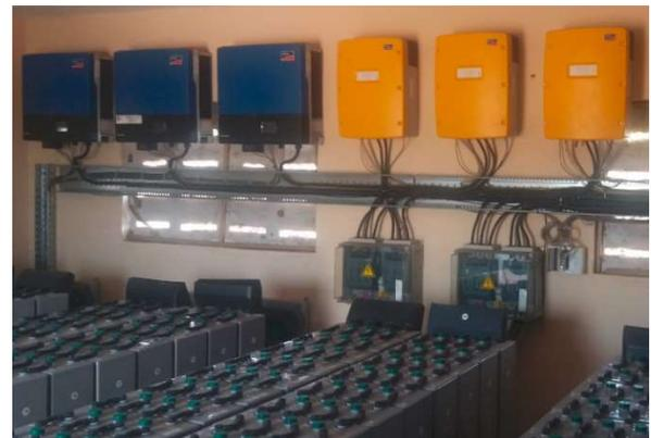
Figure 8: Parc de batteries et onduleurs du système 100% PV de Kabo (Bourgou)
